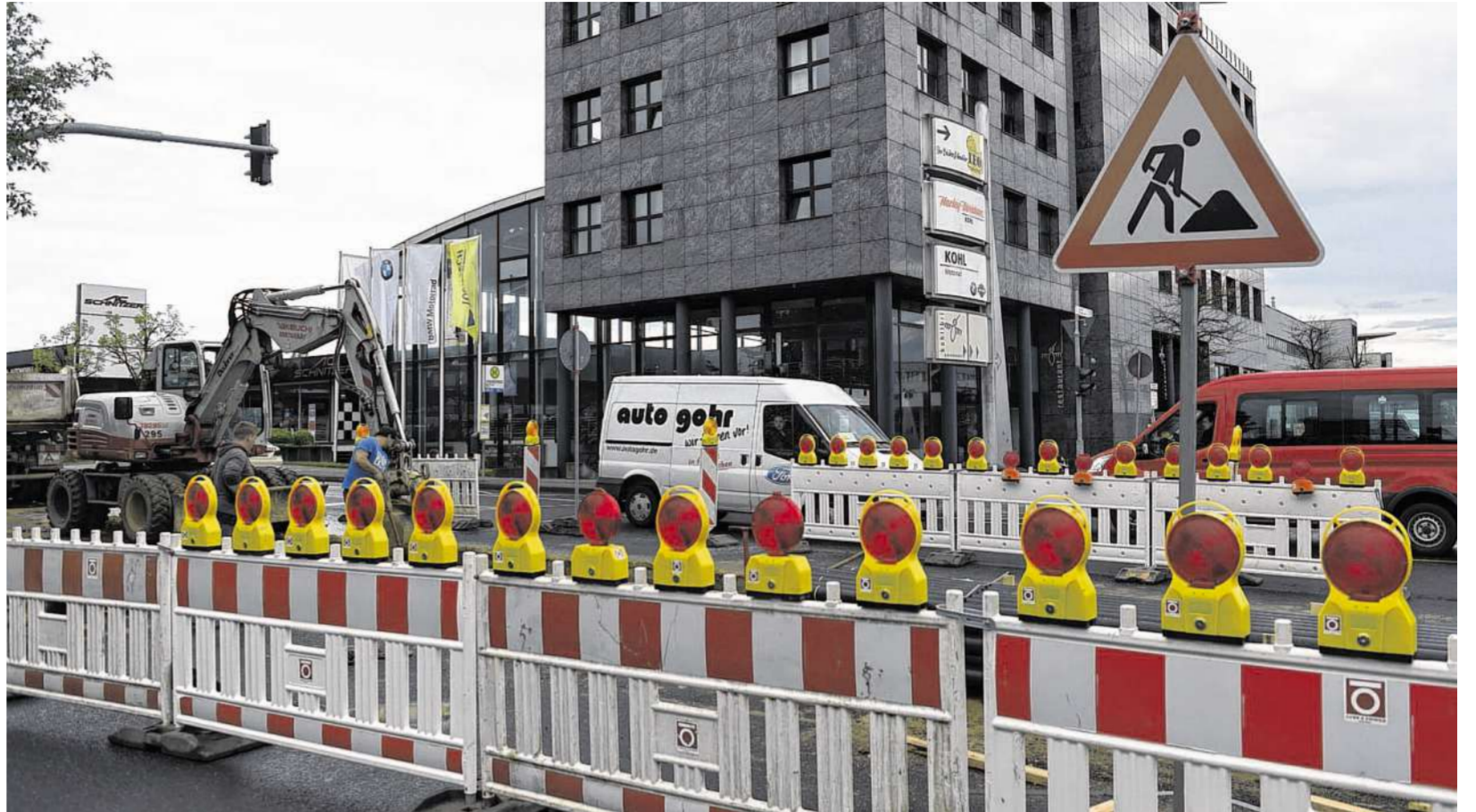
Auslöser: Seit dieser Woche Montag buddeln die Bagger auf der Kreuzung Neuenhofstraße/Zieglerstraße. Eine zunächst unzureichende Beschilderung hatte tausende Autofahrer, die den Stau umfahren wollten, in eine Sackgasse gelockt. Mittlerweile wurde nachgebessert. Foto: Michael Jaspers
